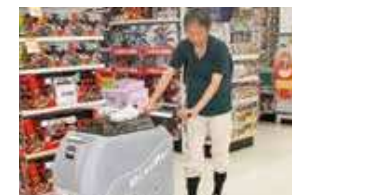
ワックスの剥離作業
