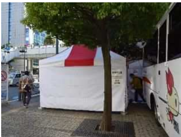
地上部にTENTや発電機を設置
