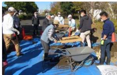
② 振るい分け後、粒の大きい順に土を埋め戻す
